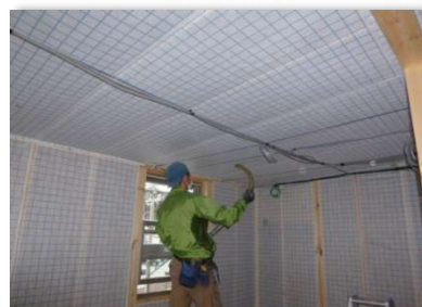
断熱材充填状況
