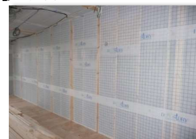
断熱材充填完了
