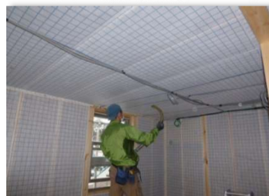
断熱材充填状況
