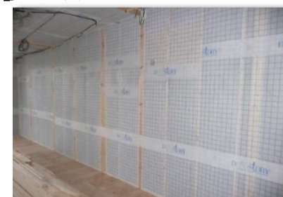
断熱材充填完了
