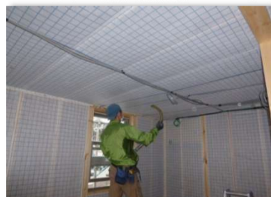
断熱材充填状況
